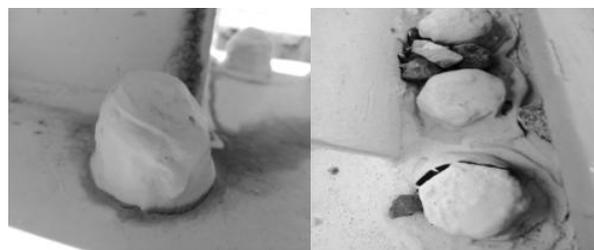
图9 某大桥护栏基座螺栓密封胶防腐方案病害图
