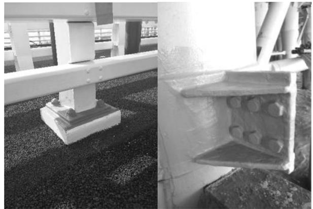
图2 螺栓包覆防腐方案
