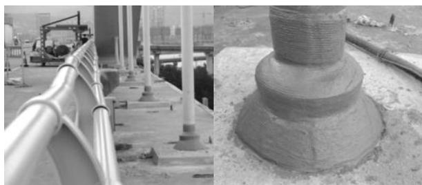
图6 温州东瓯大桥吊杆防水套包覆防腐方案效果图
