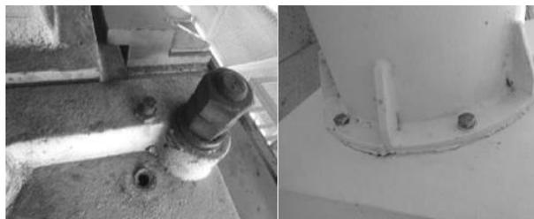
图8 舟山跨海大桥涂装防腐方案腐蚀病害图
