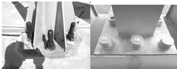
图5 螺栓油性材料和防护盖防腐方案
