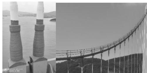
图7 舟山官山大桥吊杆防水套包覆防腐方案效果图
