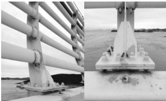
图3 螺栓常规涂层防腐方案
