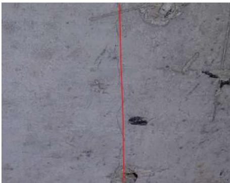
图7 顶板纵向裂缝
